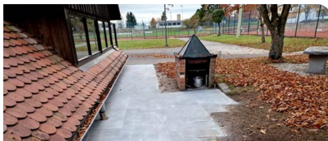
Erneuerung des Pflasters rund um das Tennisheim
