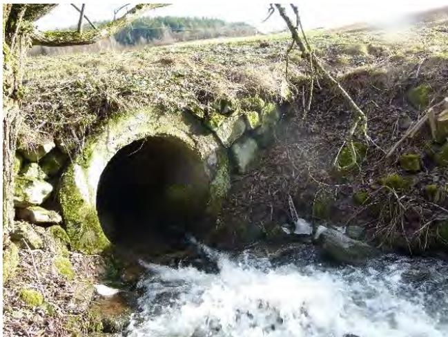
Bild 1 Durchlass Betonrohr DN 1200
