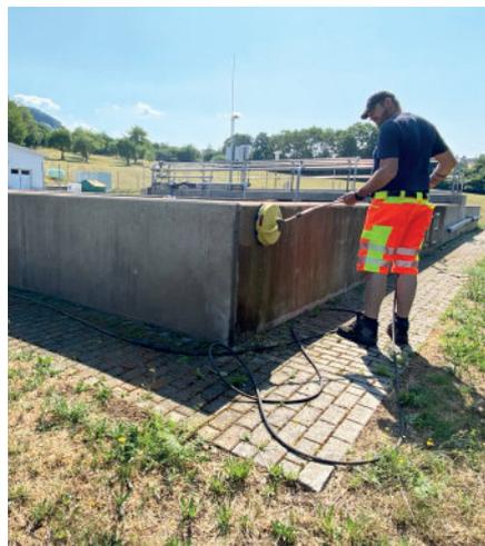
Klärwärter Arnold Stahl reinigt und imprägniert alle Betonflächen in der Kläranlage.
