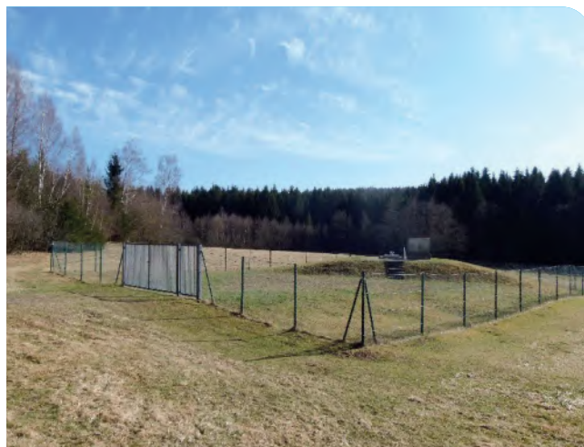
Abb. 7: Umzäunte, engere Schutzzone I des Bohrbrunnens Bursweiher I. (Foto: L. Kroll, 2021)
