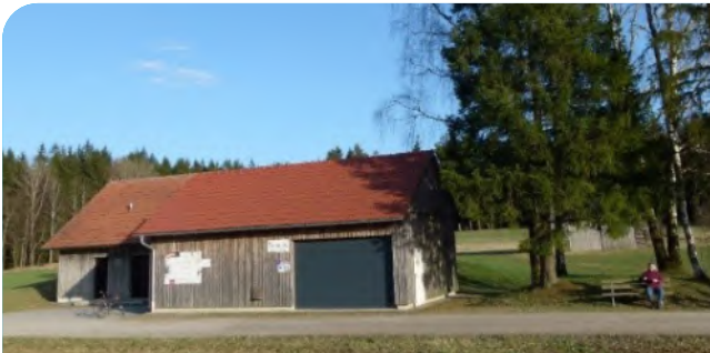
Abb. 1: Wasseraufbereitung/Hochbehälter Tannesberg: Quellwasser fließt drucklos im freien Gefälle hierher, Rohwasser vom Brunnen Bursweiher I wird ca. 72 m hochgepumpt. Das Reinwasser fließt von hier ins Verteilungsnetz. (Foto: L. Kroll, 2021)
